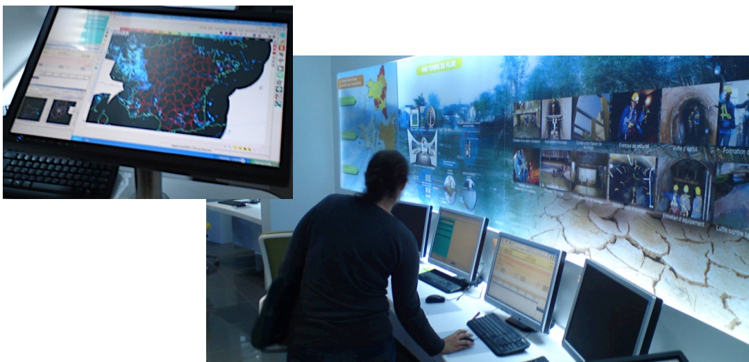
Image 7. NIAGARA : la centrale de gestion automatisée du réseau d'assainissement de la DEA (Direction de l'Eau et de l'Assainissement) du CG93. [© Auguste Gires, Leesu - École des Ponts ParisTech]
